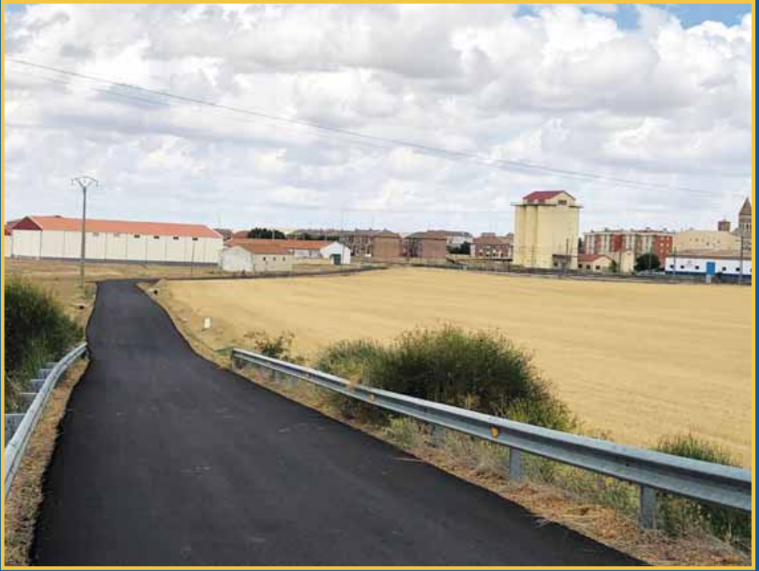
Pavimentación del Camino del Ferrocarril
