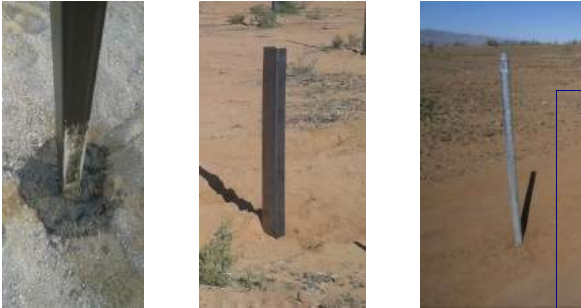
Ilustración 3: Ejemplos de hincado
